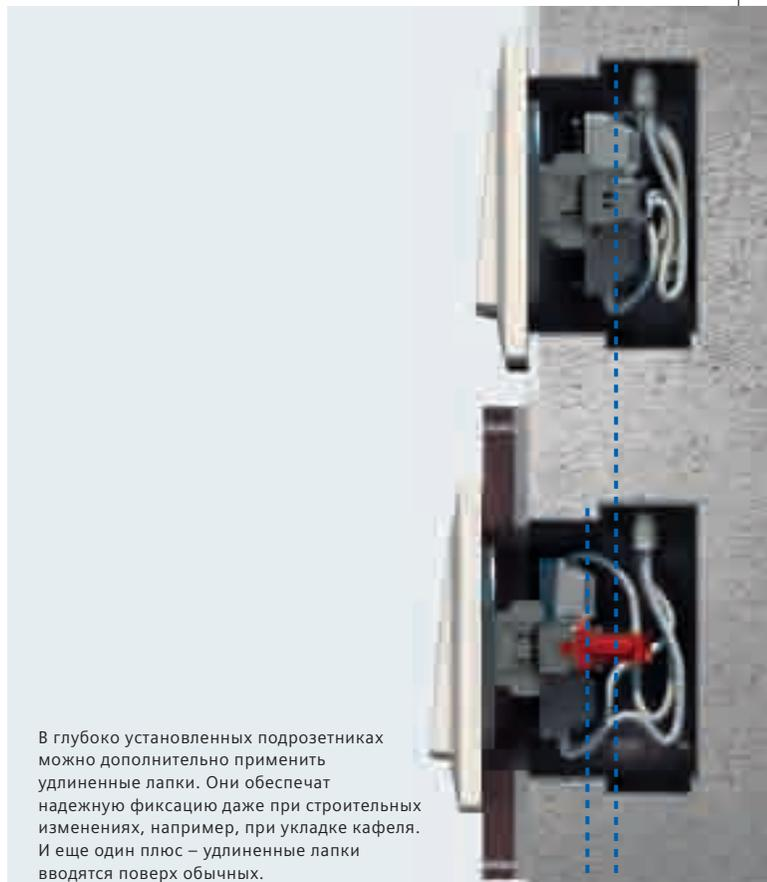
В глубоко установленных подрозетниках можно дополнительно применить удлиненные лапки. Они обеспечат надежную фиксацию даже при строительных изменениях, например, при укладке кафеля. И еще один плюс – удлиненные лапки вводятся поверх обычных.
