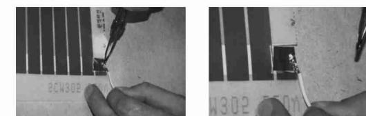
**3.2.12.** Соединения также необходимо с двух сторон изолировать двумя отрезками бутилкаучуковой изоляционной ленты размером 50 × 40 мм, которые входят в набор для подключения. Необходимо тщательно «промять» место контакта пальцами, при этом 25 мм провода должно быть покрыто скотчем.
