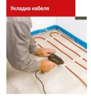
Закрепите кабель на чистом полу (например, с помощью клеевого пистолета). Нанесите слой грунтовки для клеящего состава.
